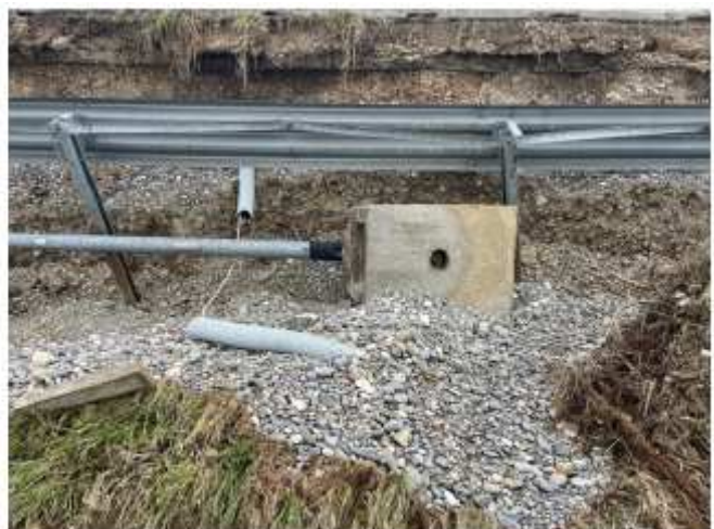
Foto 9 - Impianto di illuminazione (palo e fondazione)
